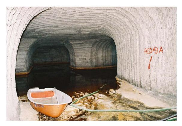
Blick in einen von mehreren Hohlräumen zur Speicherung von Lösungen aus dem Betrieb der Schachtanlage Asse II. Der Hohlraum wurde Mitte der 1980er-Jahre in 865 Meter Tiefe erstellt. Um die Speicherstrecken zu kontrollieren, Messungen vorzunehmen und Pumpen zu platzieren, nutzten Bergleute dieses Ruderboot. Heute sind diese Strecken verfüllt, das Bild stammt aus dem Jahr 2005. Was mit dem Boot geschah, ist ungewiss.
