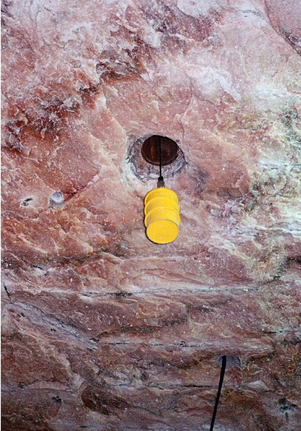
Das Bild aus dem Jahr 1972 zeigt einen Einlagerungsversuch im Bergwerk Asse. Auf diese Art und Weise gelangten zwischen 1972 und 1977 insgesamt 1301 Fässer mit radioaktiven Abfällen in die Kammer 8a. Dazu wurden sie aus einer darüberliegenden Beschickungskammer (siehe S.4) durch eine Bohrung abgeseilt. Die Einlagerungskammer 8a ist etwa 500 Quadratmeter groß und rund 14 Meter hoch. Sie liegt in einer Tiefe von 511 Metern
